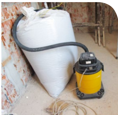
Insufflaggio in appartamento durante la ristrutturazione.
