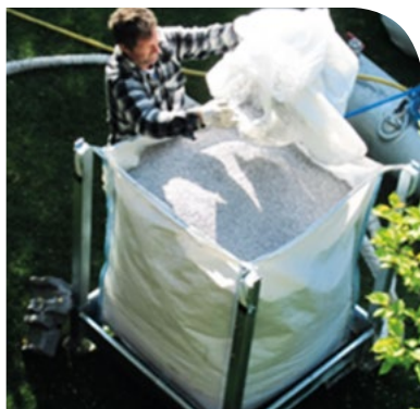
Silo di caricamento in cantiere.
