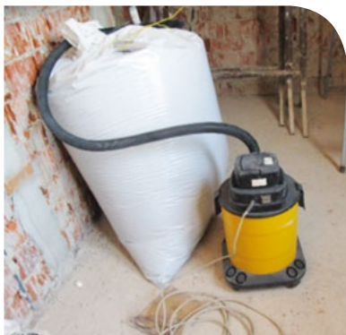
Insufflaggio in appartamento durante la ristrutturazione.
