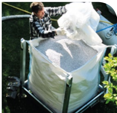
Silo di caricamento in cantiere.
