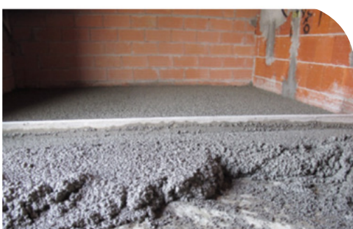
Verifica e stesura dell'impasto.
