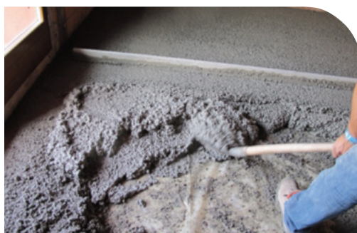
Livellamento per mezzo di staggiatura.
