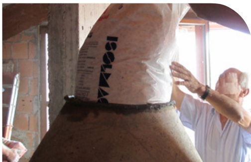
Introduzione dei componenti in betoniera.
